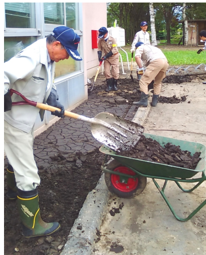
新得町民体育館の土砂を除去。
