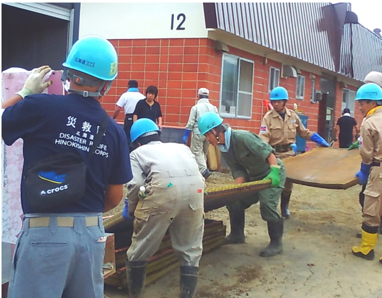
町営住宅から、どっぴりと重くなった畳を搬出。
